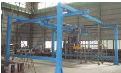
オーバーヘッド搬送機
